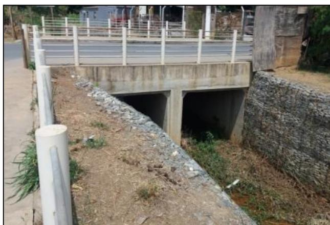
**Figura 55: Sistema de macrodrenagem existente.**
