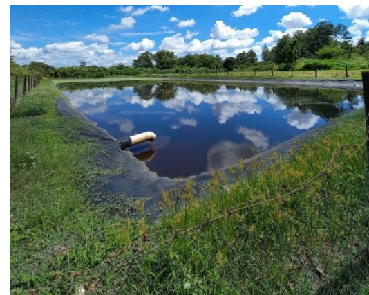
Lagoa de tratamento de esgotos em comunidade de Bambuí/MG
