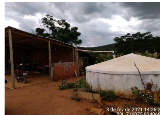
Cisternas de captação de água de chuva em comunidade rural de Mamonas/MG
