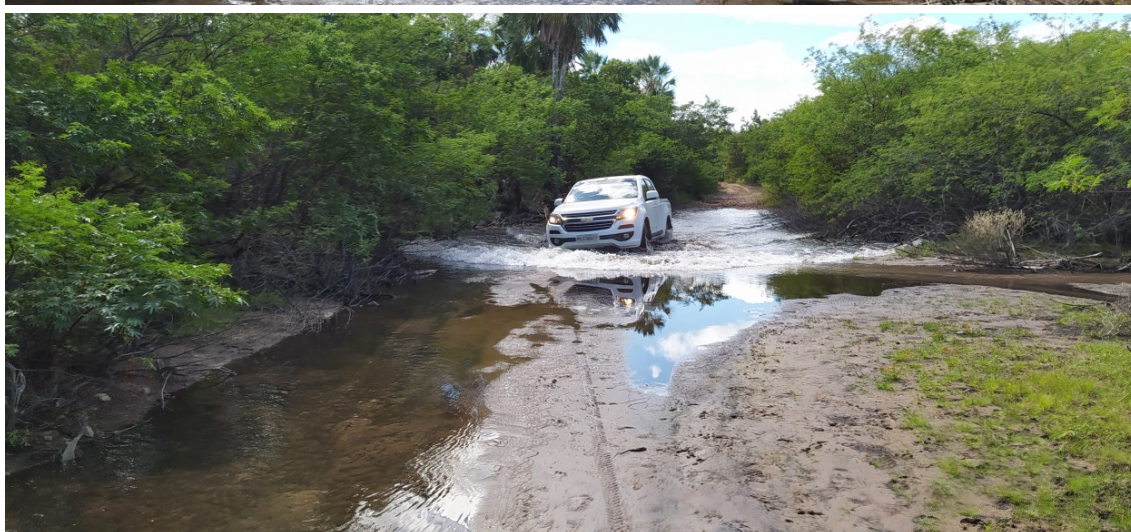
Riachos Pluviais – Encantado/ Sussuapara
