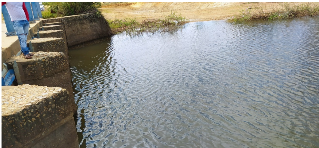
Canal de Itaparica - lado leste a montante da Lagoa de Itaparica em 06/06/2020
